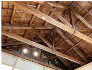
明治42年建築の「麻蔵」内部。キングポストトラスという様式の小屋組が特徴的。
