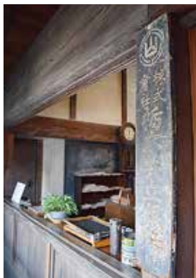
「栃木共立銀行」の木札が掲げられるカウンター。右の間屋部分と梁材が異なっているのが見て取れる。
