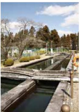
フロック形成池は、薬品に濁りの粒を付着させ「濁りの塊」(フロック)を作ります。この施設にも開設当初からの煉瓦積みや緑石が残されています
