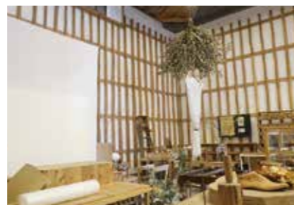
東棟のアトリエは木材を格子状にした「荷摺木」を残す
