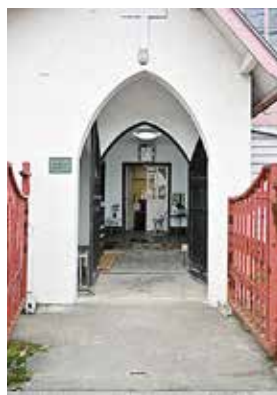
尖頭アーチの玄関ポーチが特徴的な教会入口
