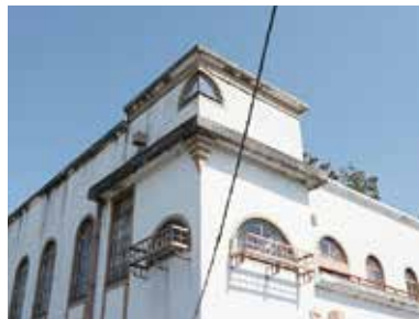
屋根付近には半円を角に施した装飾もみられます
