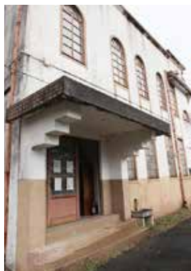
建物の西側もアーチ型の窓枠でデザインされています
