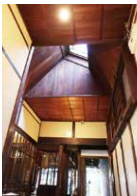
土間の天井には天窓も設けられています
