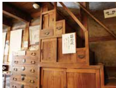
急な段差に収納スペースが設けられている箱階段
