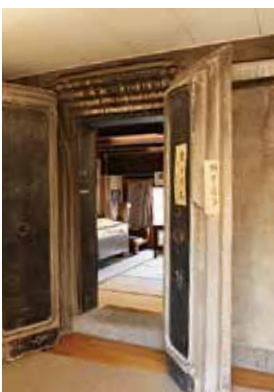
厚さ約17cmの観音開扉。防火にすぐれた掛子造りです
