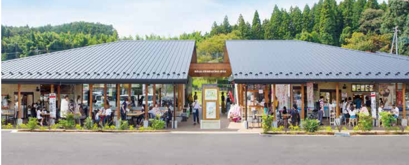
▲大谷石の外壁と開放的な窓が特徴的。広いテラスでひと休みもできます。
