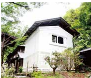
主屋東側に建つ置屋根形式の2階建土蔵。
