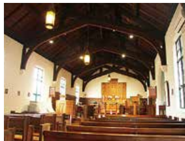
礼拝堂内部は、シザートラスで組まれた天井の梁が印象的
