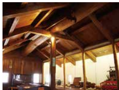
蔵2階の天井部分、松の一本通しの中引き梁が見事
