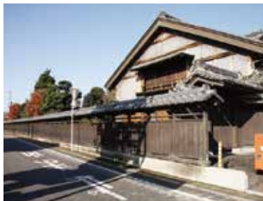
石橋と真岡を結ぶ旧道沿いの建物南側
