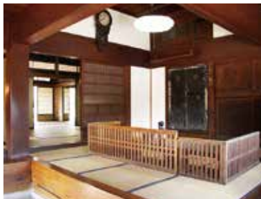
店舗内部。樺の大黒柱や梁が見事
